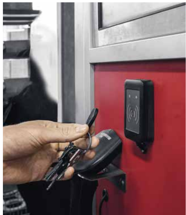
Praktisch: Die Anmeldung der Mitarbeiter im System erfolgt über Transponder, die auch sonst bei der Zahn GmbH eingesetzt werden.
